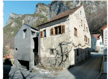
Fläsch: Casascura, der Erweiterungsbau aus schwarzem Beton ersetzt den Stall
